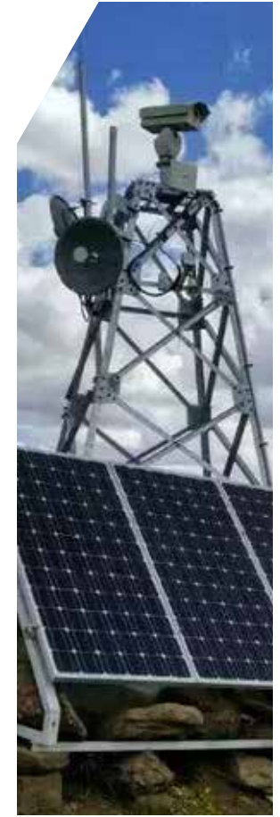
Perimeter Neimenggu China
